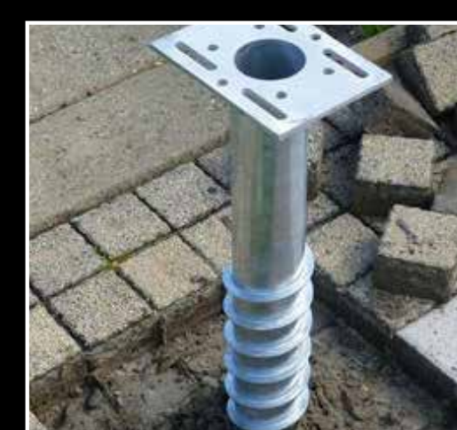
Schroefpaal fundering
